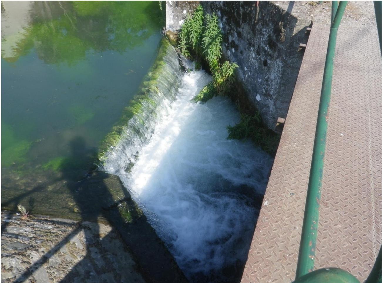
Il s'agit d'un ouvrage de type batardeaux composé d'une assise bétonnée de 10 cm et de trois planches de 30 cm en chênes pour permettre l'élévation du niveau d'eau.
