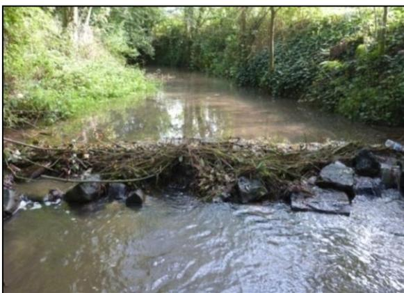
Présence d'un seuil en enrochement de taille trop important par rapport à la hauteur de la ligne d'eau sur le Scardon (tronçon Sca-Am2). Les débris de feuilles et de branches ainsi que les sédiments sont retenus en amont et créent des embâcles.
