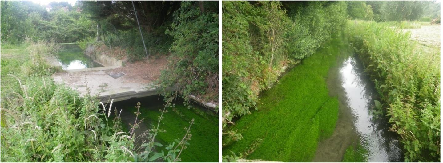
La ligne en amont de l'ouvrage présente une pente très faible de 0,955 ‰. Une prise d'eau est implantée en rive gauche à une distance de 157 m en amont du moulin. Initialement utilisée pour les bassins de l'ancienne pisciculture (aujourd'hui comblés), cette dérivation alimente les étangs de la PLP d'Abbeville mentionnés plus tôt. En juillet 2015, le débit dérivé par la prise d'eau était de 0,11 m<sup>3</sup>/s soit 7,6 % du débit de la rivière.
