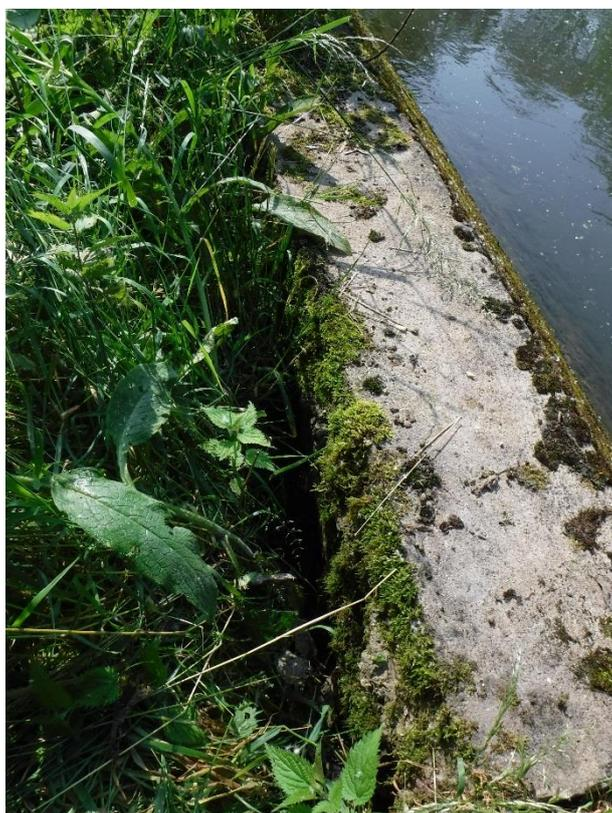
*Vue sur le Scardon canalisé ainsi que sur les fissures et affaissements en berges*
