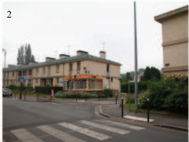
Vue des logements rue Engrand Leprince
