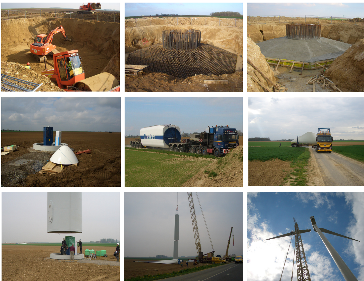
Photographie 2 : Aperçu des différentes phases de travaux
