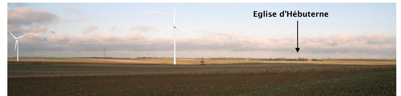
Depuis la RD129e passant au sud du site d'implantation
